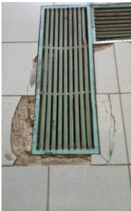
Sistema de drenagem do pátio com necessidade de reparos
