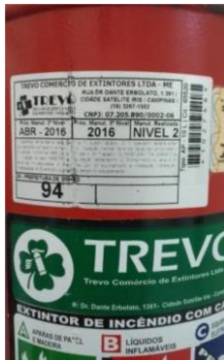
Extintor de incêndio com validade expirada
