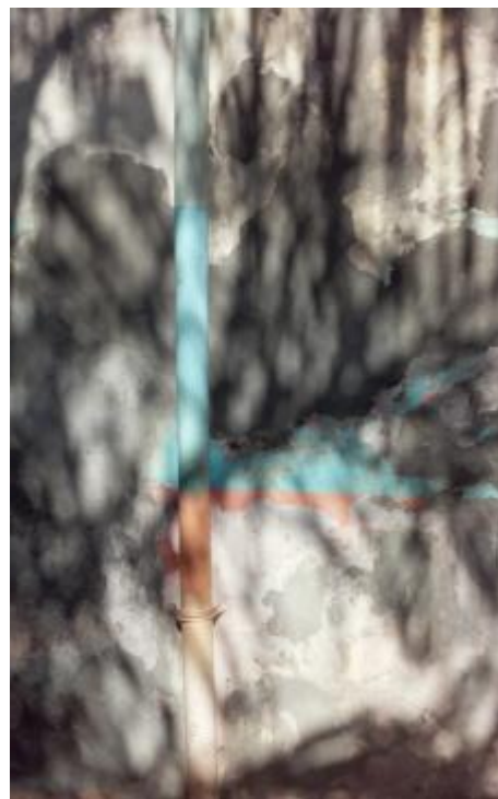
Paredes com mofo causado por infiltração
