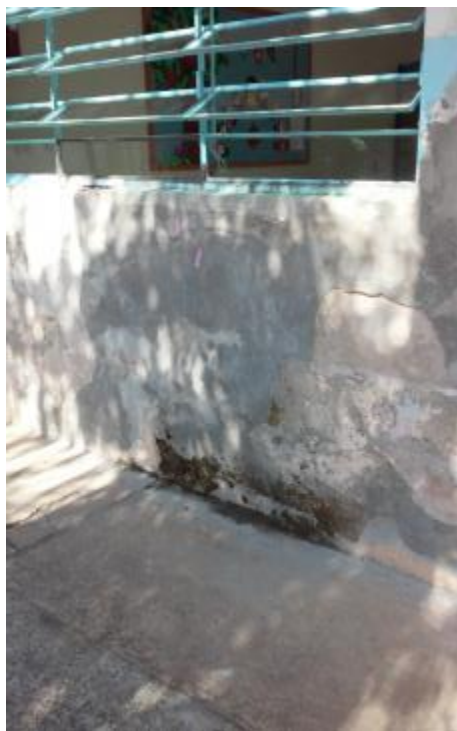
Paredes com mofo causado por infiltração
